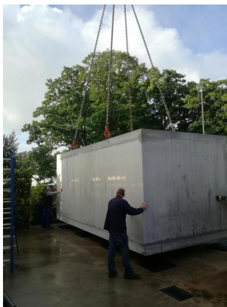
Plaatsen pekelopslagtank 35.000 liter in 2017
